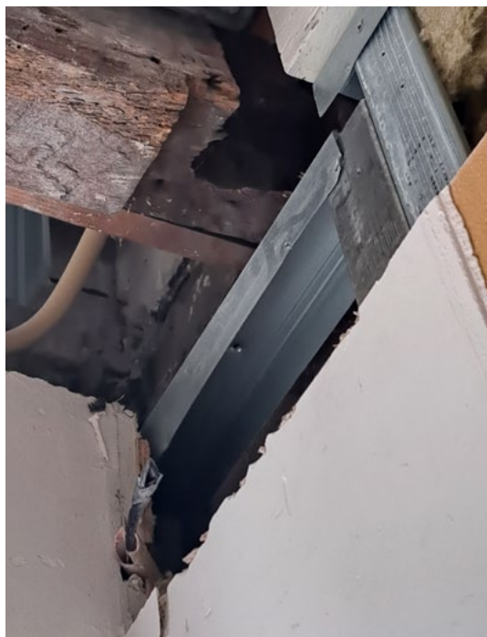
31. Aanpassing houtconstructie vanwege verzakking (Foto: Vera Kuijpers)
