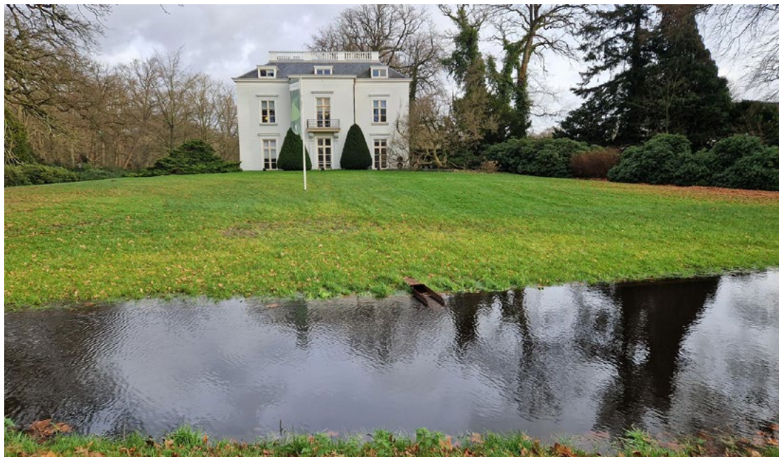
21. Als onderdeel van het project Klimaatrobuuste Buitenplaatsen is de monumentale slingervijver op buitenplaats Hoog Beek en Royen in Zeist hersteld.
